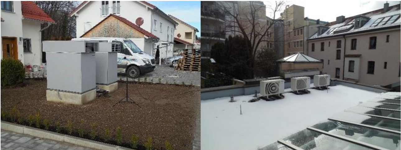
Abbildung 1: Typische stationäre haustechnische Anlagen in der Umgebung von Wohnbebauung
