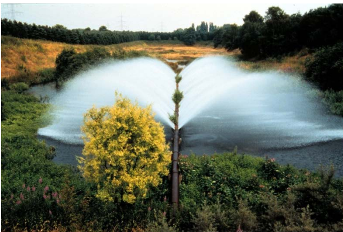
Abbildung 14: Versickerungsanlage des Wasserwerkes Weiler in Betrieb
