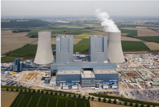
Abbildung 1: Rundkühlturm: Naturzug-Nasskühlturm (links) und Kühlturm mit drückend angeordnetem Ventilator (rechts)
