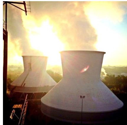
Abbildung 1: Rundkühlturm: Naturzug-Nasskühlturm (links) und Kühlturm mit drückend angeordnetem Ventilator (rechts)
