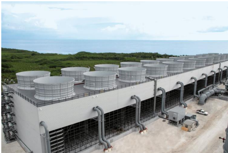
Abbildung 2: Serienkühlturm in Zellenbauweise mit saugend angeordnetem Ventilator
