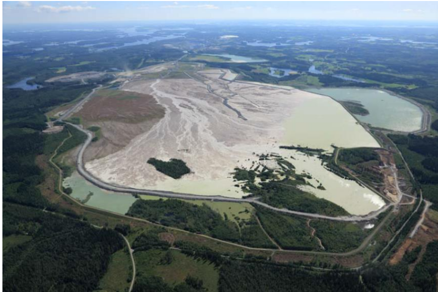
Abbildung 13-6: Schlammteich für Flotationsschlämme, vor der Inbetriebnahme des Eindickers
