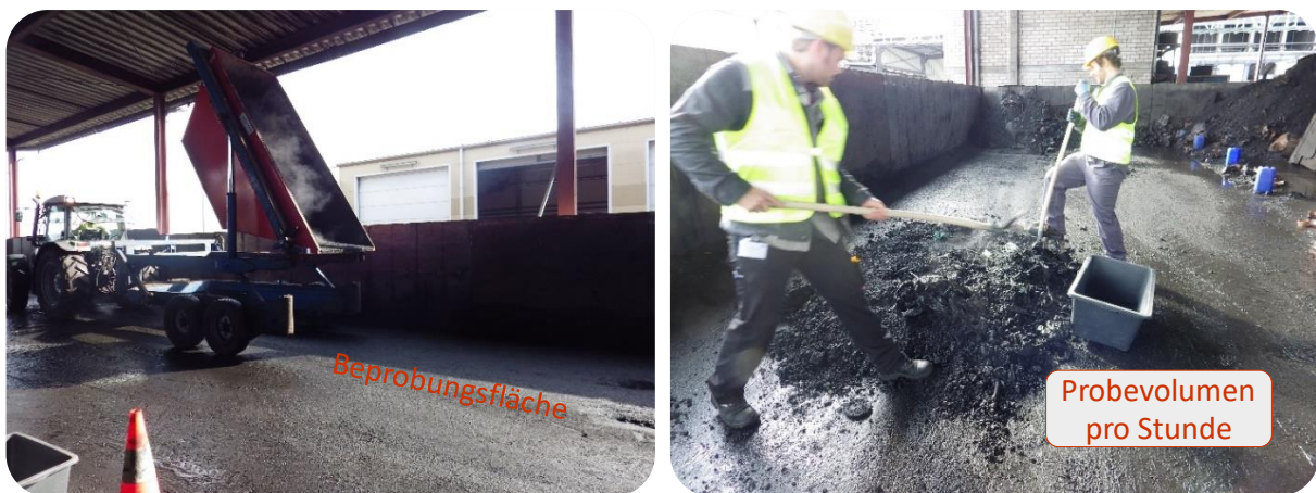
Abbildung 26: Entleerung der Mulde (links), und Schlackebeprobung (rechts).
