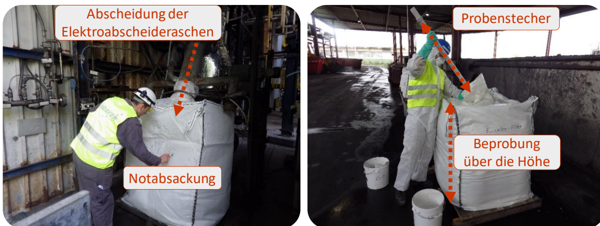
Abbildung 28: Notabsackung der Rückstände des elektrischen Abscheiders (links), Beprobung der Rückstände mittels Probenstecher (rechts).
