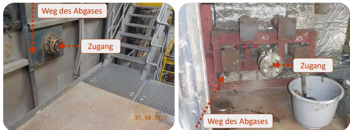
Abbildung 30: Messstellen für die Partikelgitternetzsonde.
