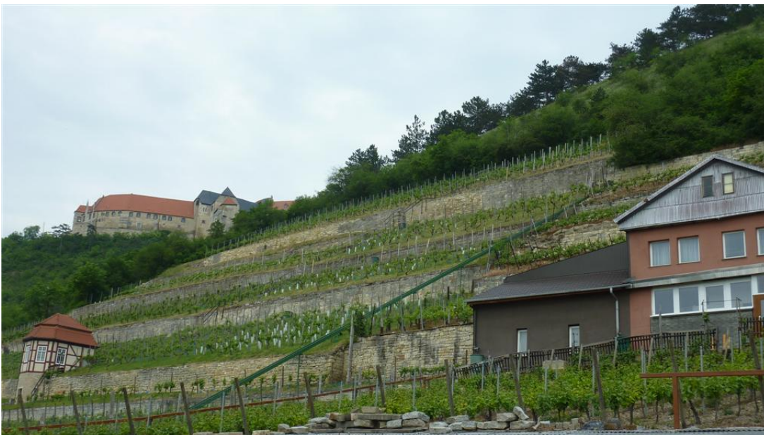
Abbildung 20: Schloss Neuenburg, Herzoglicher Weinberg südlich Freyburg. Detailansicht.
