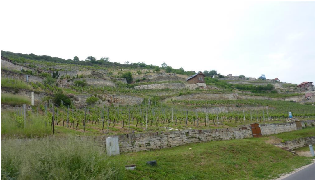
Detailansicht Freyburger Schweigenberg mit Trockenmauern.
