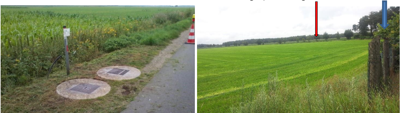
Abbildung 10: Foto der Messstellengruppe (links; Unterflurausbauten) sowie des Umfeldes (rechts, die Pfeile markieren den Messstellenstandort und den Rand eines offenen Güllelagers) in Kleinringer Wösten
