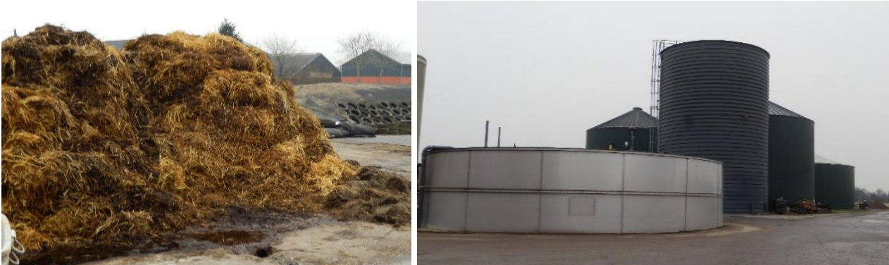
Abbildung 35: Lagerung von Stallmist (links) und Biogasanlage mit Zapfstelle (rechts)
