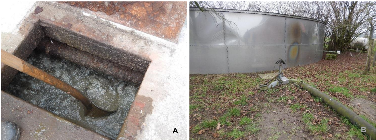
Abbildung 34: Arten von Güllelagerstätten (Foto A: Blick in Güllekeller, Foto B: Güllehochbehälter (eigene Aufnahmen)
