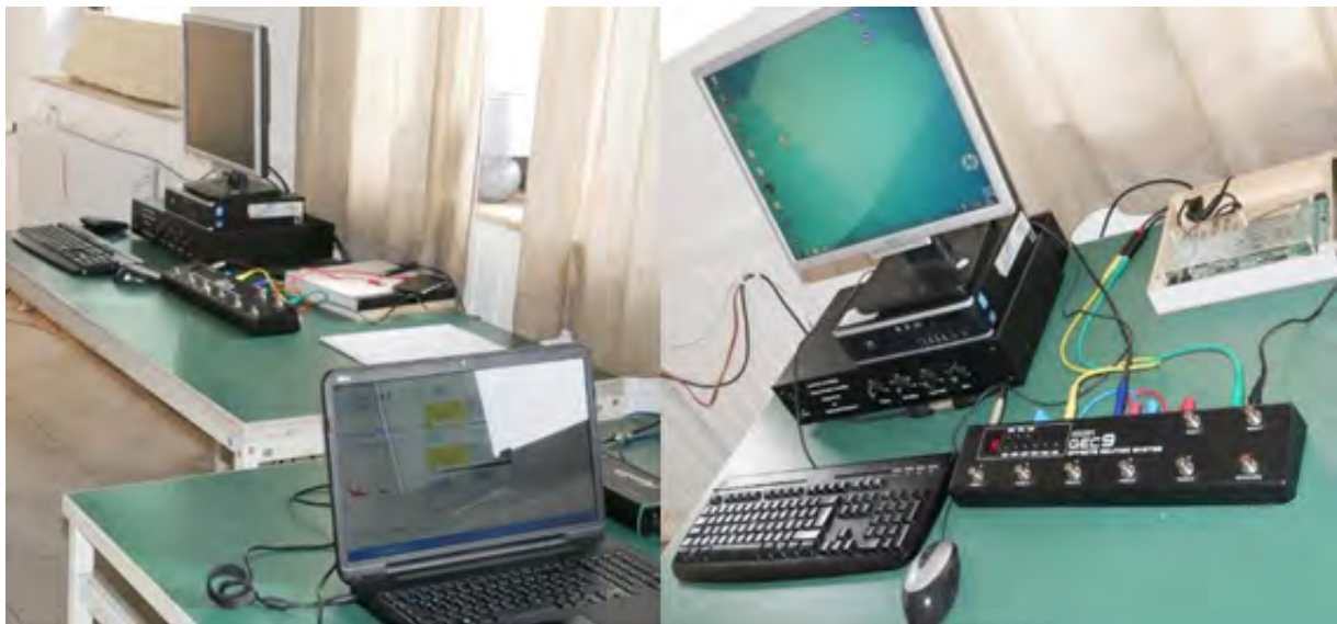
Abbildung 23: Systeme und Arbeitsplätze im Kontrollraum
