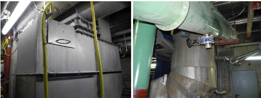
Probenahmestellen Rückstandsproben: Probenahmestelle 4 Klärschlamm eintrag vor Kessel (links); Probenahmestelle 5 Ascheaustag (rechts).
