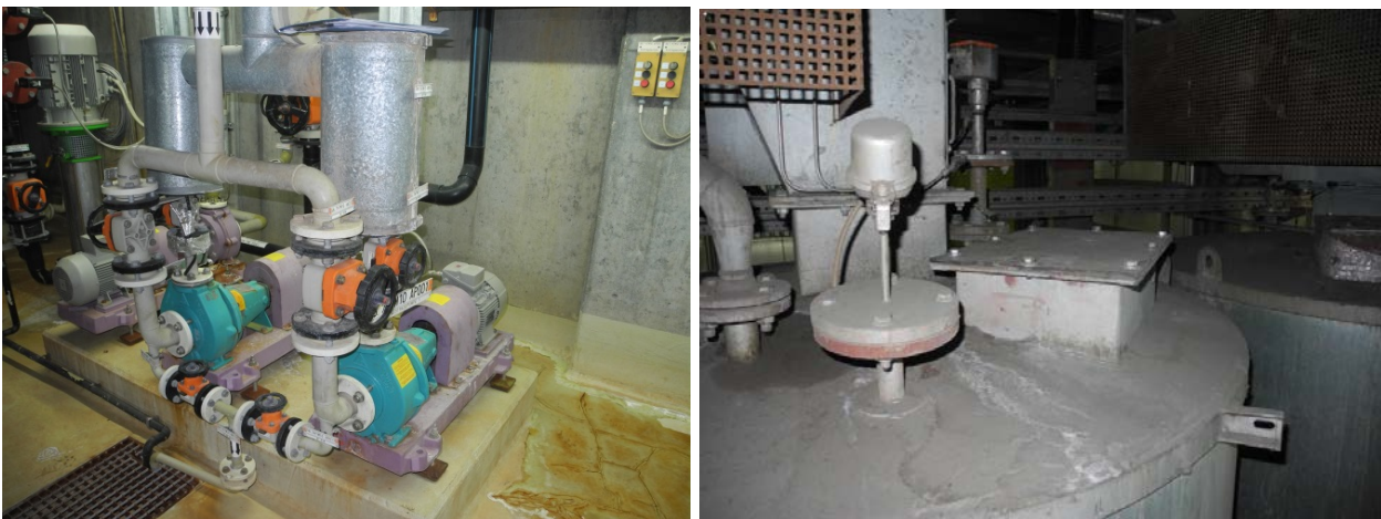
Probenahmestellen Rückstandsproben: Probenahmestelle 7 Waschwasser (links); Probenahmestelle 6 Aktivkohle (rechts).
