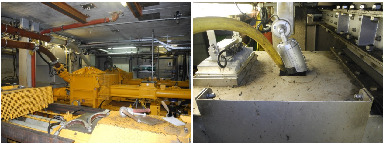
Einbringung TiO 2 Material: Feststoffpumpe (links); Einbringung TiO 2 Material (rechts).
