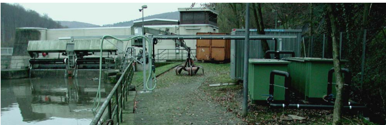
Abb. 30: MIGROMAT® am Wasserkraftstandort Wahnhausen an der Fulda mit zwei Hältertanks, Wasserzu- und -ableitung
