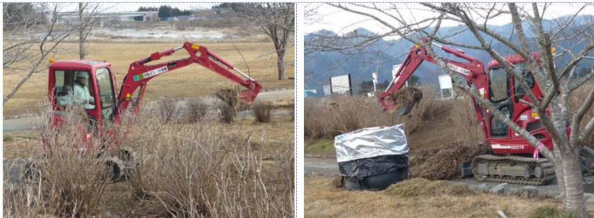
Abb. 2.6 Dekontamination durch Abtragen der Vegetation und der obersten Bodenschicht.
