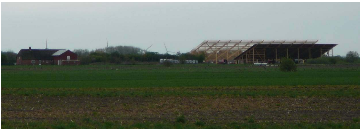
Abbildung 7: Dachflächenphotovoltaikanlage auf speziell für diesen Zweck errichtetem Gebäude
