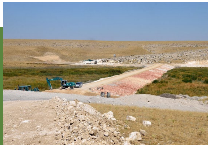
Bau eines Damms zum Wasserrückhalt in einem Talmoor in der Türkei
