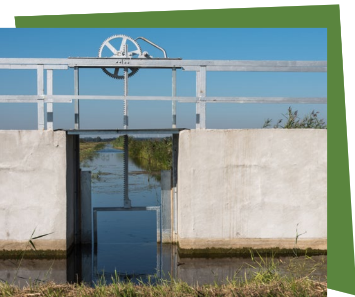
Sanierter Stau in einem Graben zur Wiedervernässung eines Niedermoors
