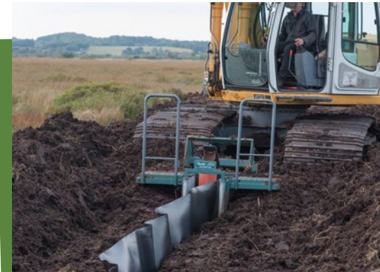
Wiedervernässung eines Hochmoores; Einbau einer wasserstauenden Folie in einem Torfdamm zum Wasserrückhalt
