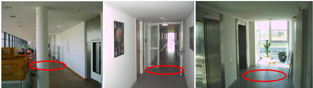
Bild III.2.36: Messpunkte 8. OG_Links, 5. OG_Mitte und 3. OG_Rechts bei Gebäude 3
